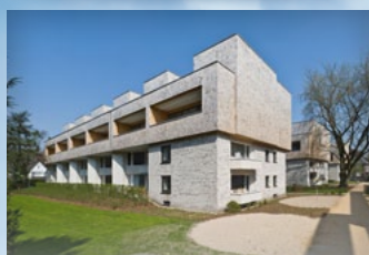
Nástavby bytových domů
